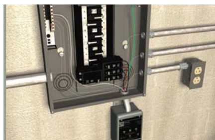
Diagrama de instalación de un supresor de picos 42120-DY3
